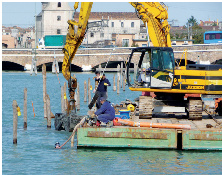
Posa condotta sublagunare
