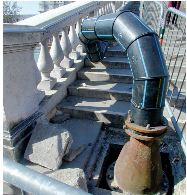
Lavori Ponte degli Scalzi a Venezia
