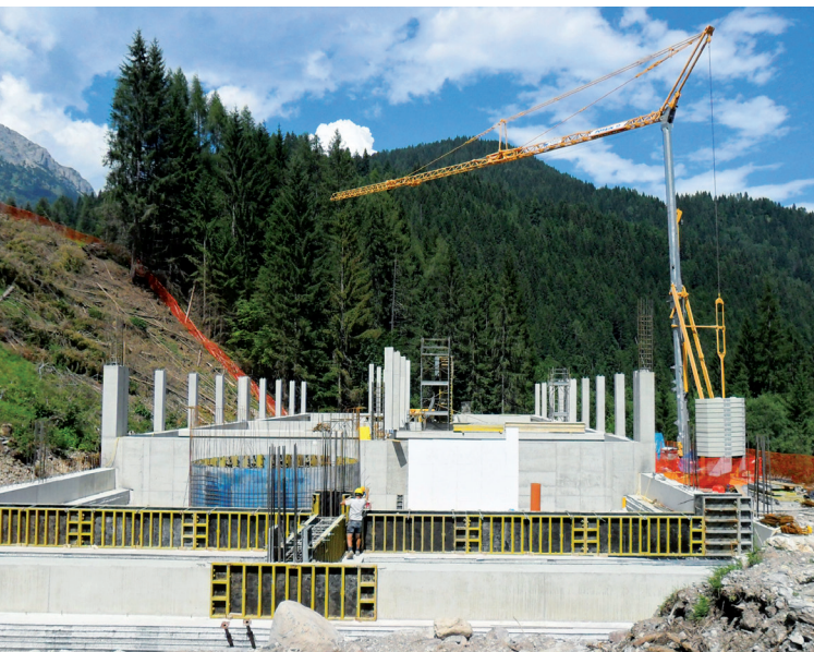
Costruzione nuovo depuratore a Falcade (BL) – Bim Gsp
